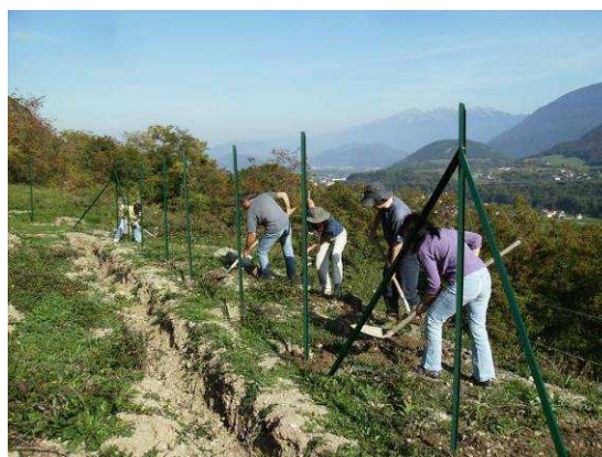
Chantier du 16 octobre 2011
