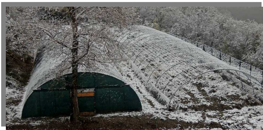
Les deux volières de 28 m de long
