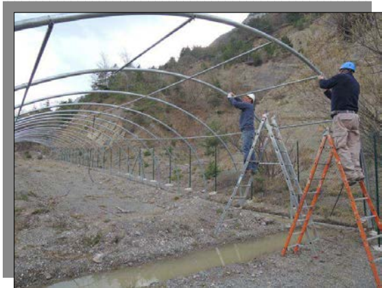
Montage des arceaux volière 44m (Photos Tichodrome)
