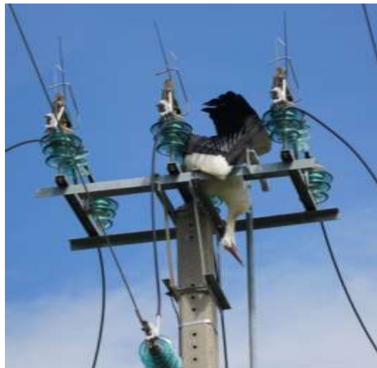
Cigogne électrocutée sur un poteau IACM, Monestier du Percy. Photo Jean-Charles Poncet.
