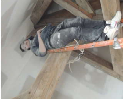
Ponçage des poutres
