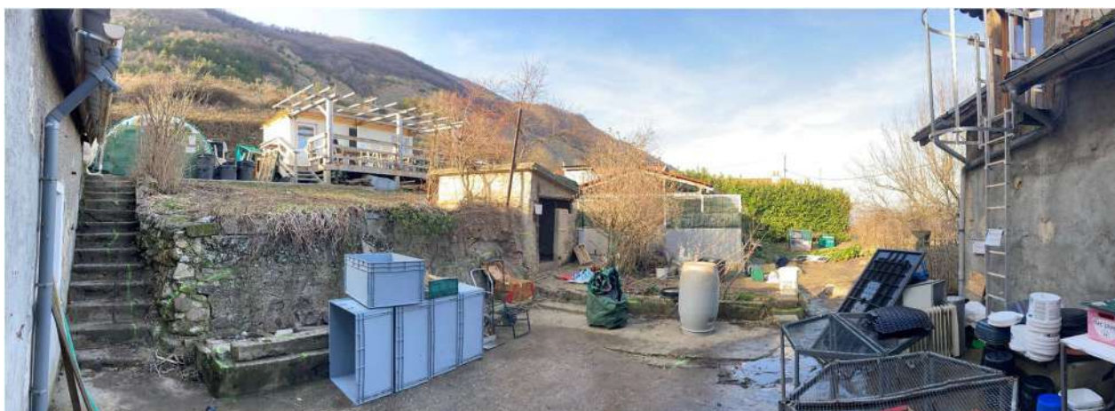
COUR NORD - AVANT LES TRAVAUX
