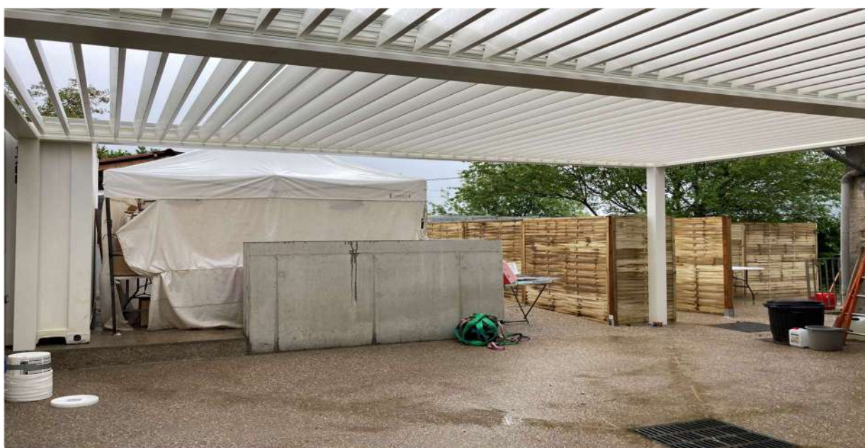
COUR NORD - APRES LES TRAVAUX
